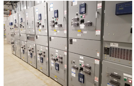
Switchgear
